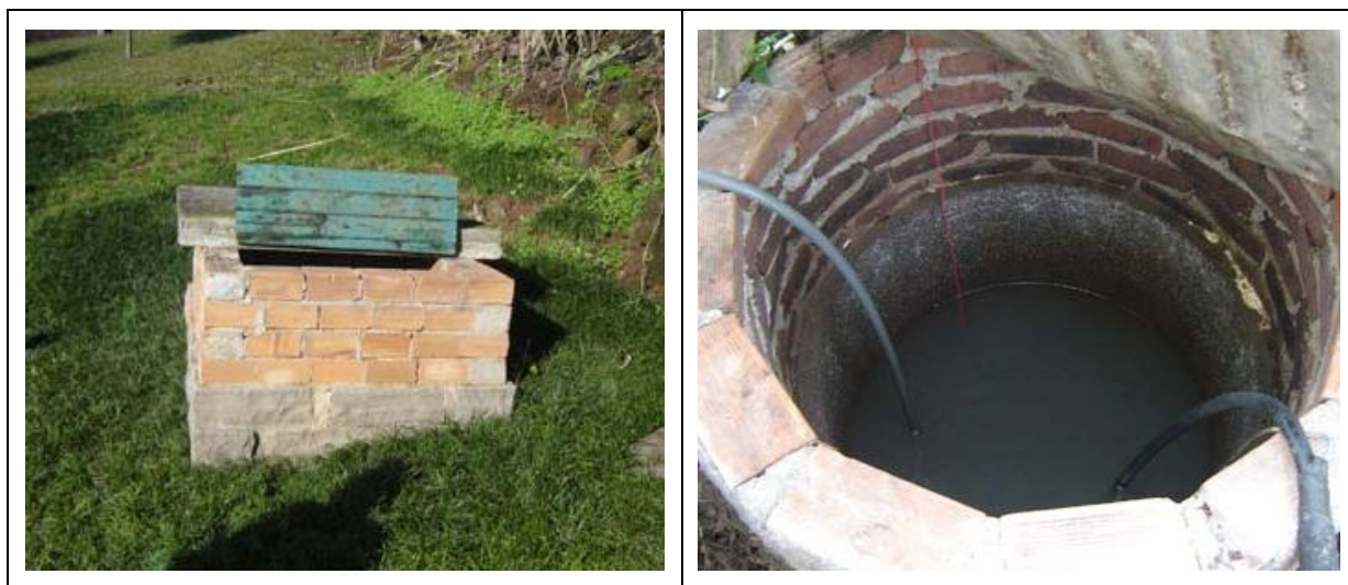
Figura 5. Poços escavados (tipo cacimba) cadastrados na área de estudo.
