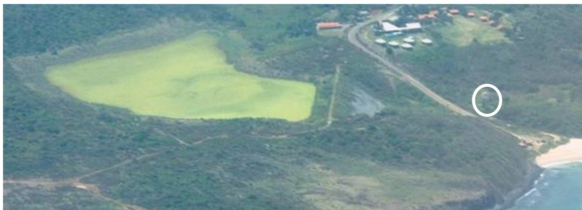
Figura 5. Vista do açude Xaréu em 22 de setembro de 2004. Detalhe para o ponto de captação de água de escoamento subterrâneo da barragem.
