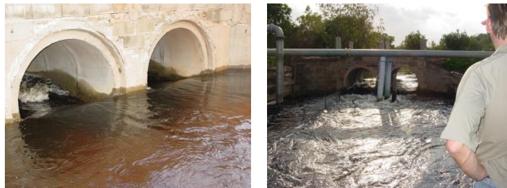
Figura 3. Vista dos bueiros: de montante e de jusante, respectivamente.
