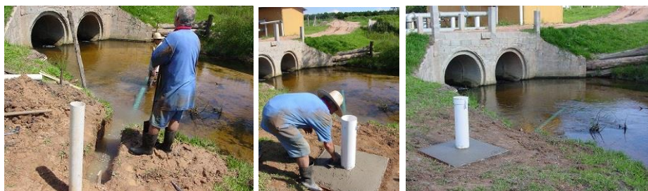
Figura 4. Instalação do limnígrafo a montante do bueiro.
