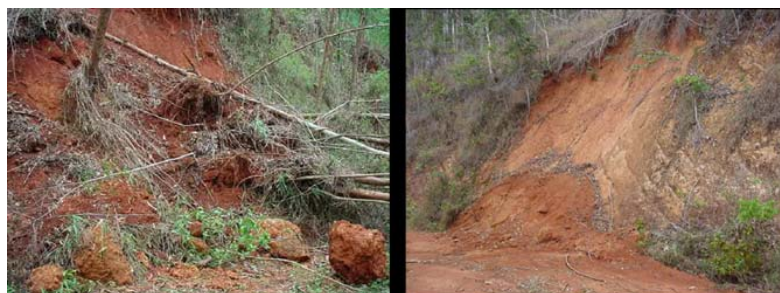
Figura 10. Desmoronamento de taludes na bacia hidrográfica da Cachoeira das Pombas, Guanhães, MG, 2004.
